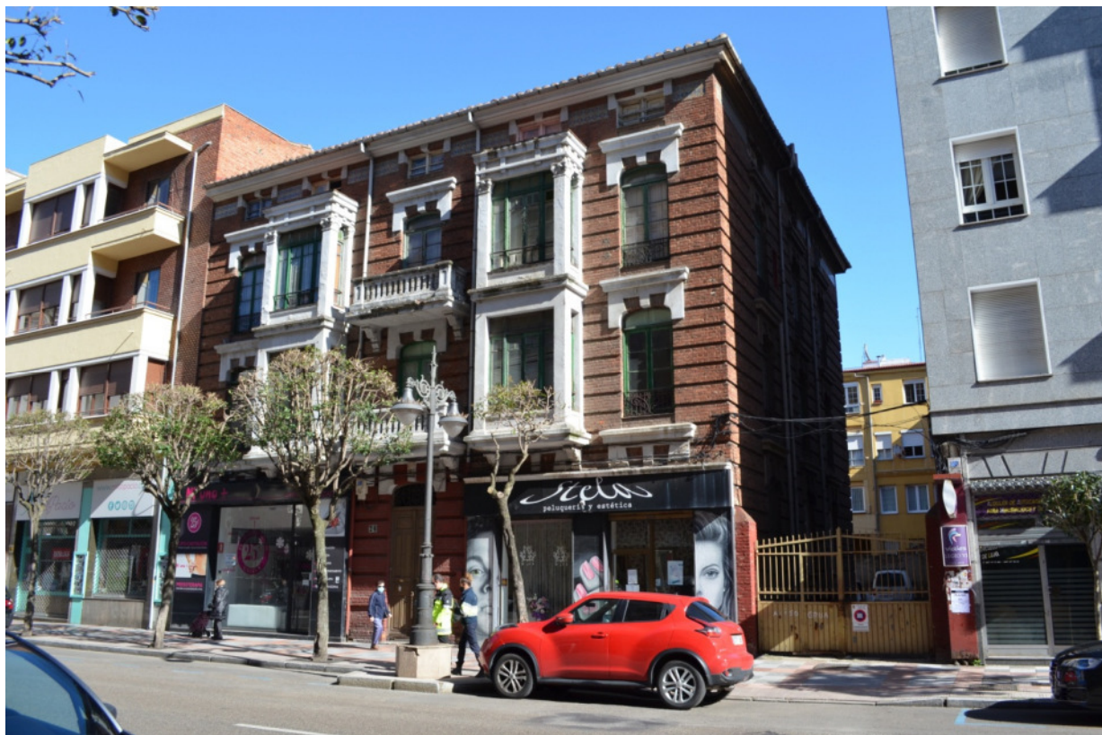
fachada principal (a la izda., edificio incluido en la ficha 45 del catálogo)
